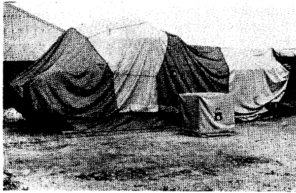
FIG. 5—A DRICLAD COMPLETE ENCLOSURE
