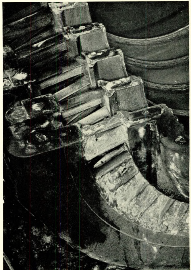
FIG. 14—g.t.v. Goodwood—Choked turbine inlet nozzles
